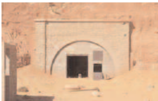
Entrée d'un tunnel sur la zone CEA de Reggane 17 novembre 2007. Photo Bruno Barrillot.
